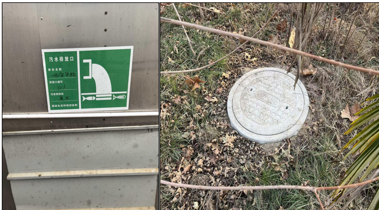
图 3-4 污水排放口、化粪池
