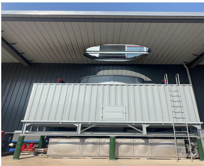
循环冷却池：3 米宽*5 米长*2 米高
