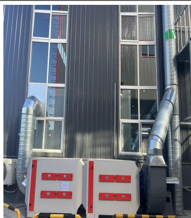
补漆烘干废气处理装置
