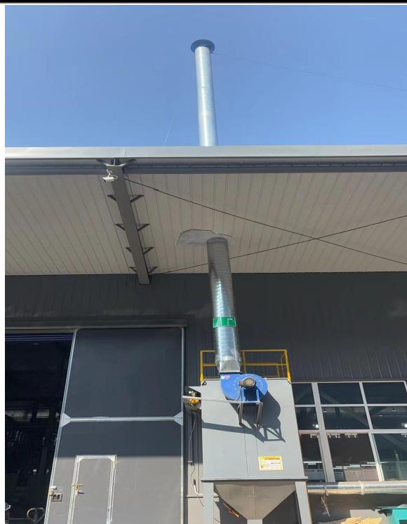
粉碎工序废气布袋除尘器+15 米排气筒 DA002 及监测平台
