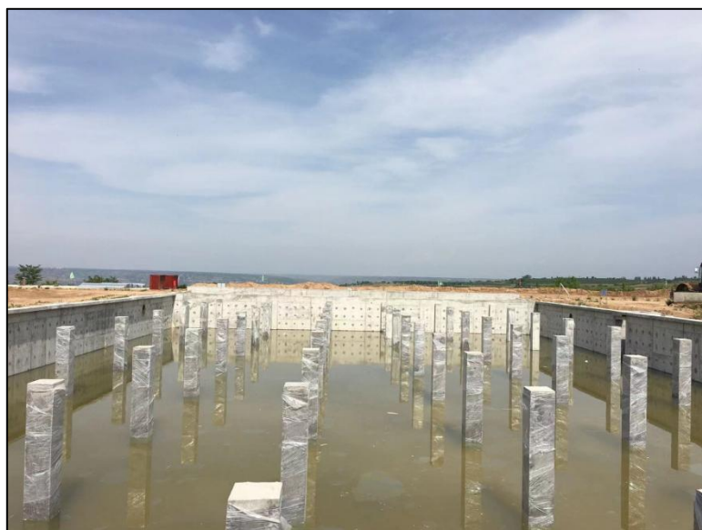
图 4.1-2 猪舍下方粪污储存池蓄水试验防渗图
